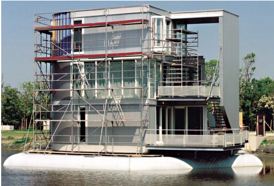
De waterwoning van Hertzberger, mei 2004. Het demonstratiemodel wordt voorzien van een grotere derde verdieping. (foto Frank Bos)
