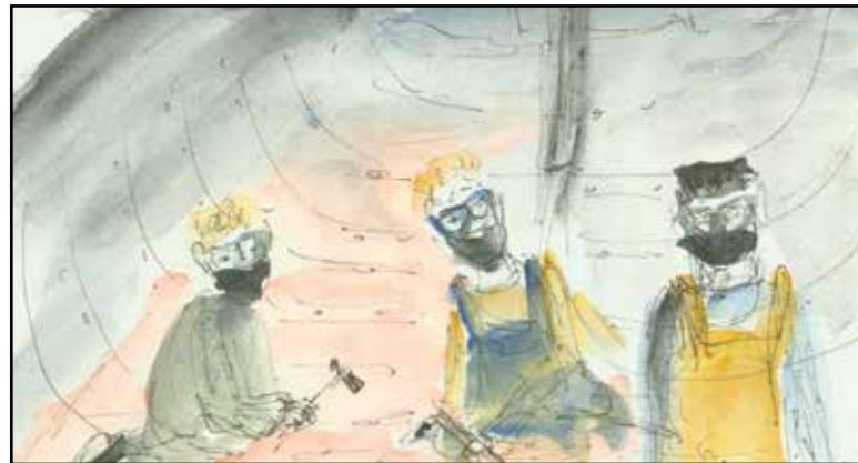
het grote slopen is begonnen
