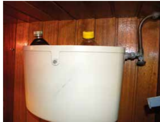
De stortbak met reeds 'geïnstalleerde' frisdrankflessen. Wie dit iets netter wil uitvoeren kan op zoek gaan naar geschikte, maar minder hoge flessen (eventueel van glas).
