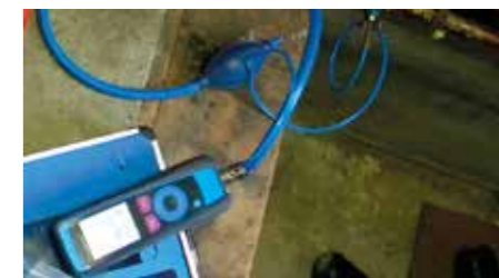
Controle van de gasleidingen: afpersen en controle dat de druk niet weglekt. Geslaagd!
