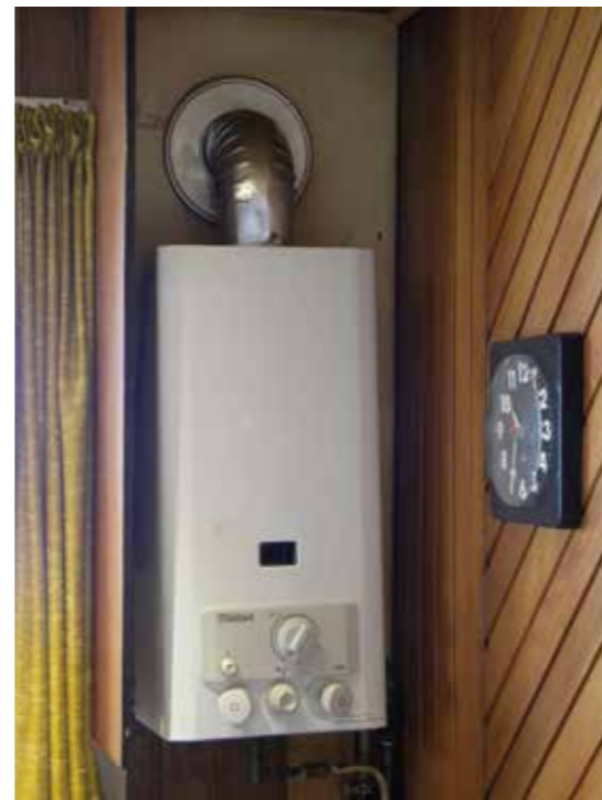
Een typische keukengeiser van een jaar of twintig terug. De fabrikanten van elektrische boilers hebben modellen op de markt gebracht die als vervanger van een dergelijke geiser zijn bedoeld. De ruimte voor de rookpijp wordt hierbij benut om de capaciteit te verhogen.
